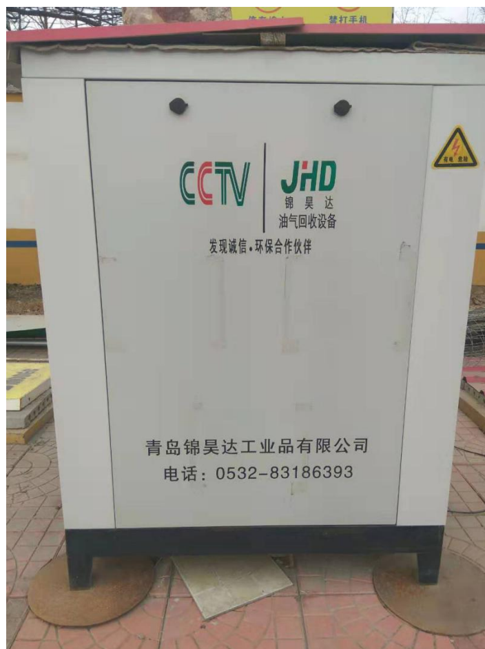
三次油气回收装置
