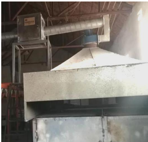
集气罩 + 活性炭吸附装置 + 15m 排气筒
