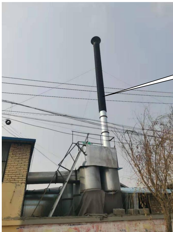
15m开松混料、梳理废气排气筒P1
