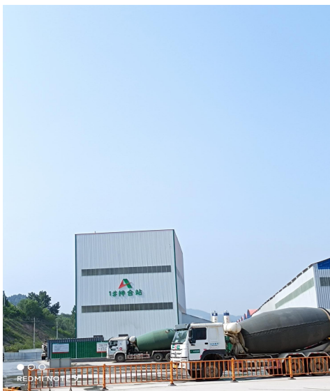
商混站搅拌站
