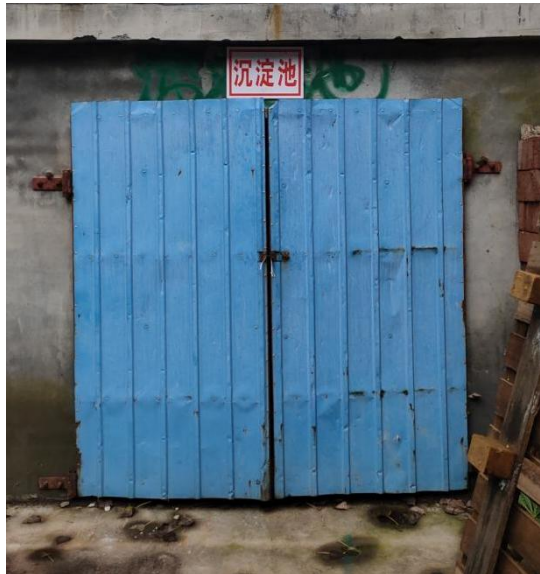
沉淀池检查口
