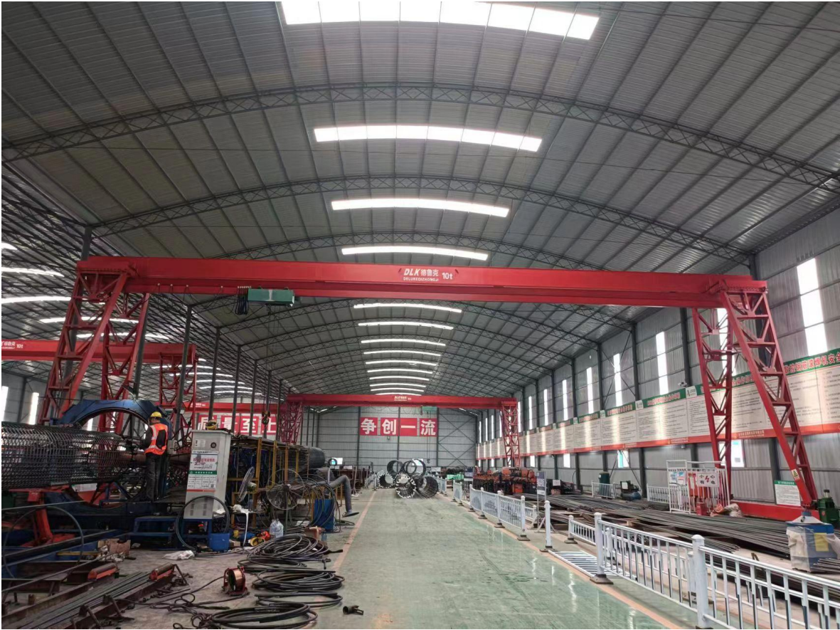
钢筋加工车间（m 2 ）
