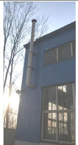
东厂区硅橡胶压延成型、模压成型工序集气罩+2#活性炭吸附装置+15 米高排气筒 P2
