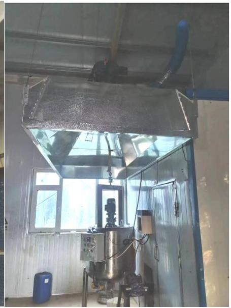
东厂区 空心芯棒搅拌、浸胶固化工序收集装置+1#活性炭吸附装置+排气筒 P1
