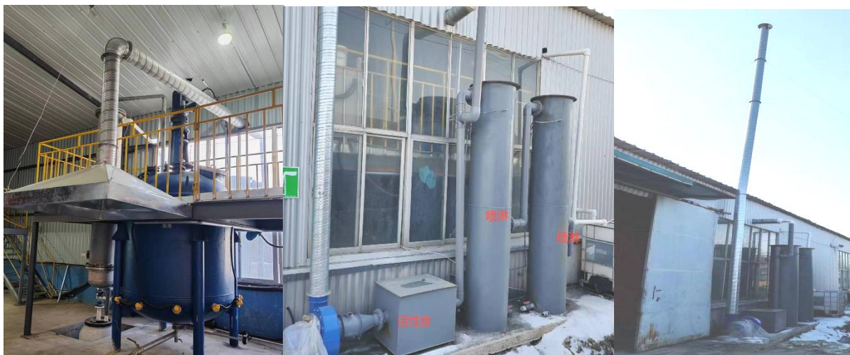
微生物肥发酵废气排气筒 DA002
