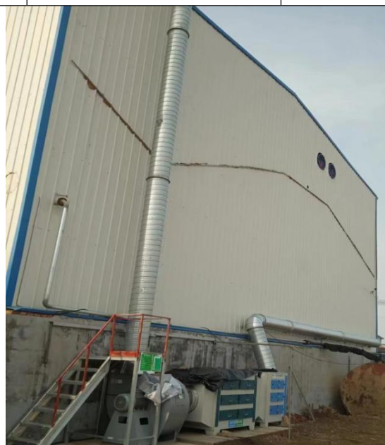
两级活性炭吸附装置+排气筒 DA002
